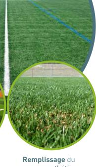
Remplissage du gazon synthétique avec le système choisi : sable et/ou caoutchouc et/ou liège
